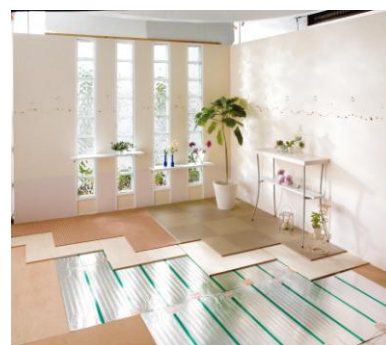
床材の下に設置
